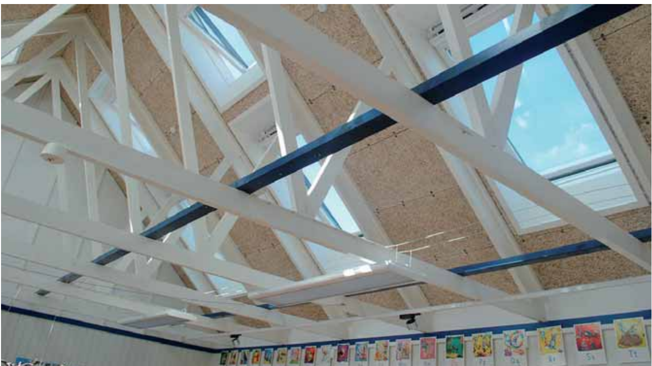
Instalación de Velux en un colegio danés.
